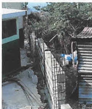
Foto 5: fundición de cemento y levantado de muro perimetral.
