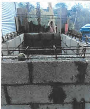
Foto 1: levantado de paredes de pila.
