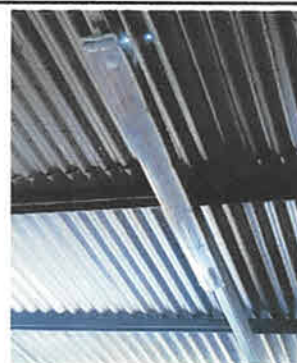
Foto 4: instalación de lámparas tipo listón en cada salón de clases.
