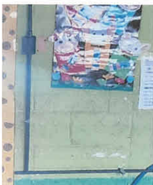
Foto 3: colocación de poliducto para instalación de cableado eléctrico por aula.
